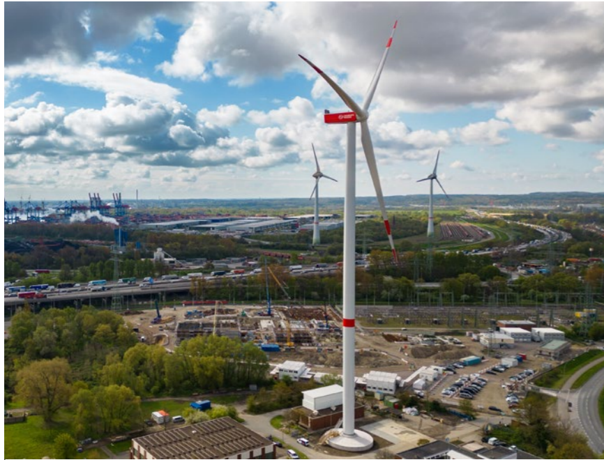
Einzig neue Anlage im Hamburger Stadtgebiet versorgt Klärwerk mit Strom.
