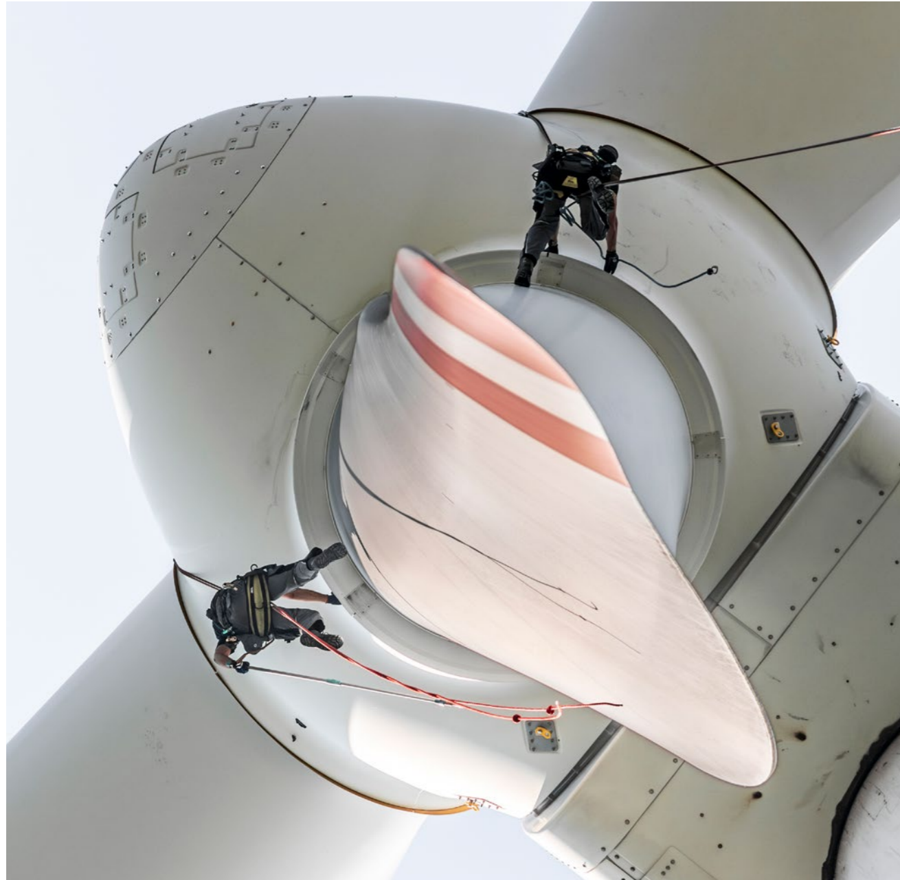
Industriekletterer beim Abstieg über Maschinenhaus und Nabe zum Arbeiten am Rotorblatt einer Windkraftanlage.
